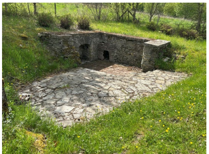
Abb. 13: Teil der Heizanlage des römischen Landguts in Kinheim-Kindel.
