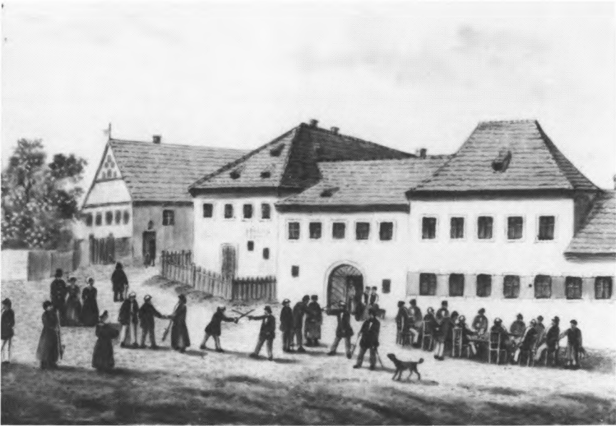
Der ehem. Gasthof auf dem Gelände des Fürstenkellers
