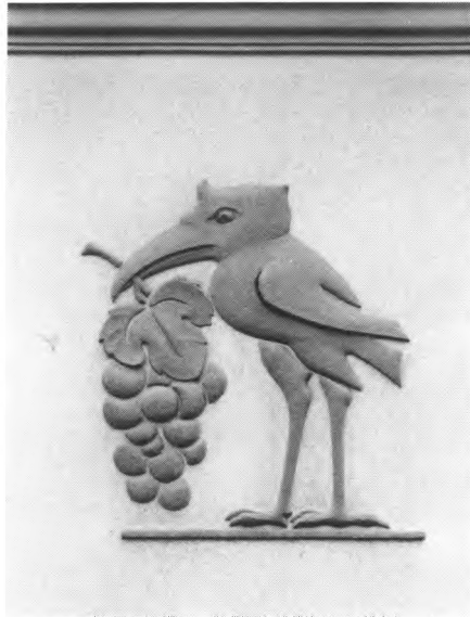
Putzrelief an der ehem. Gaststätte „Rabenburg“ an der Neugasse
