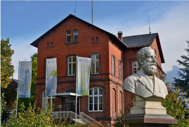
Abb. 9: Verwaltungsgebäude der Hochschule Geisenheim University (aus der Gründungszeit) mit dem Denkmal Eduard von Lades
