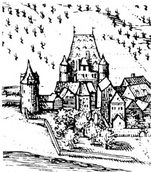
Abb. 7. Die kurfürstliche Kellerei, das Verwaltungsgebäude des Amtes Zell mit ausgedehnten Kelleranlagen. Hier übernachtete Kaiser Maximilian im März 1512.
