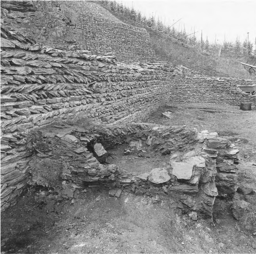
Abb. 22. Blick auf die nördliche Abschlußmauer von Raum 3 mit dem unverkennbaren Fischgrätenmuster (opus spicatum).
