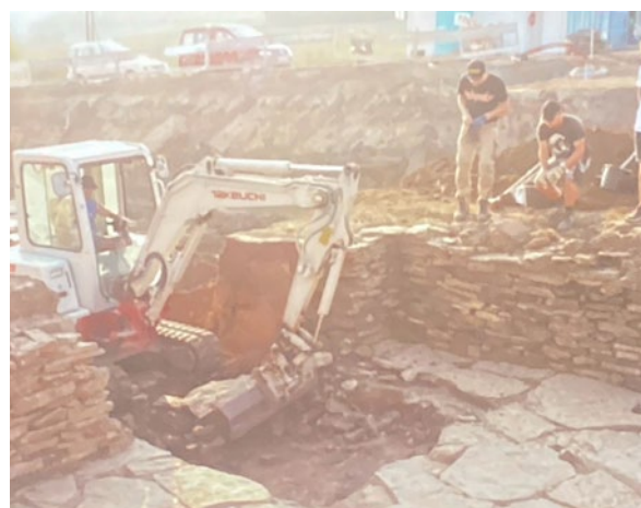
Abb. 16: Foto gezeigt während des Vortrags von Günter Brücken. Der möglicherweise planmäßig geräumte (?) Keller wurde zerstört und beseitigt.
