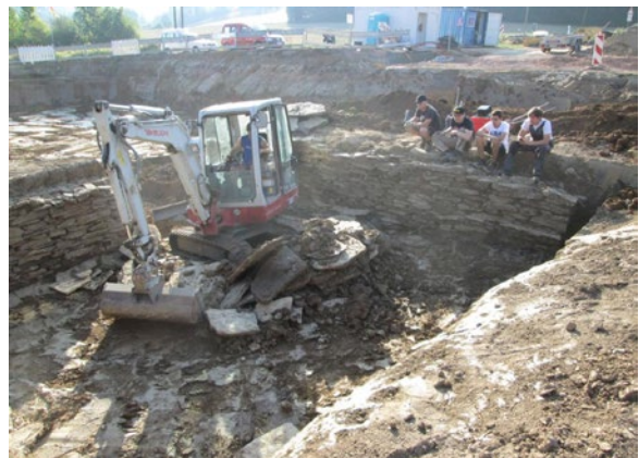
Abb. 14: Keller I mit Bagger. Ausstellung/Dokumentation Odernheim 2016.
